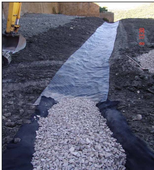
Figura 2.5/VII: Canalette di drenaggio acque meteoriche
