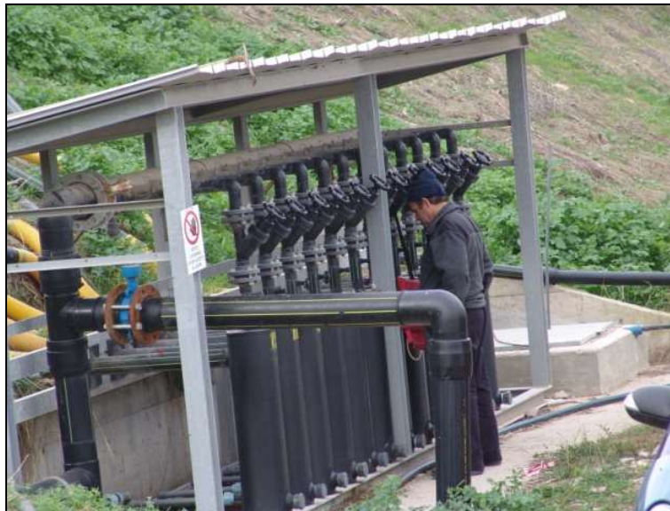
Figura 2.5/VIII: Sottostazione rete drenaggio biogas
