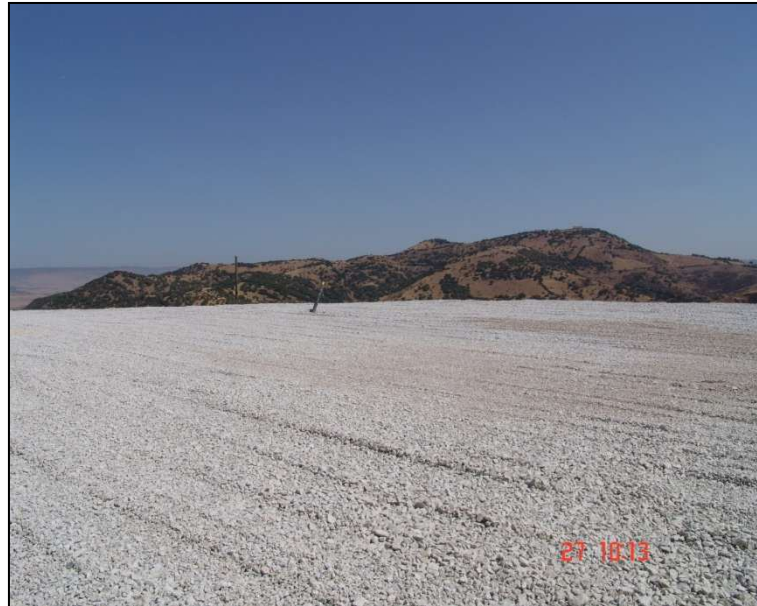
Figura 2.5/IV: Stesa strato drenante superficiale
