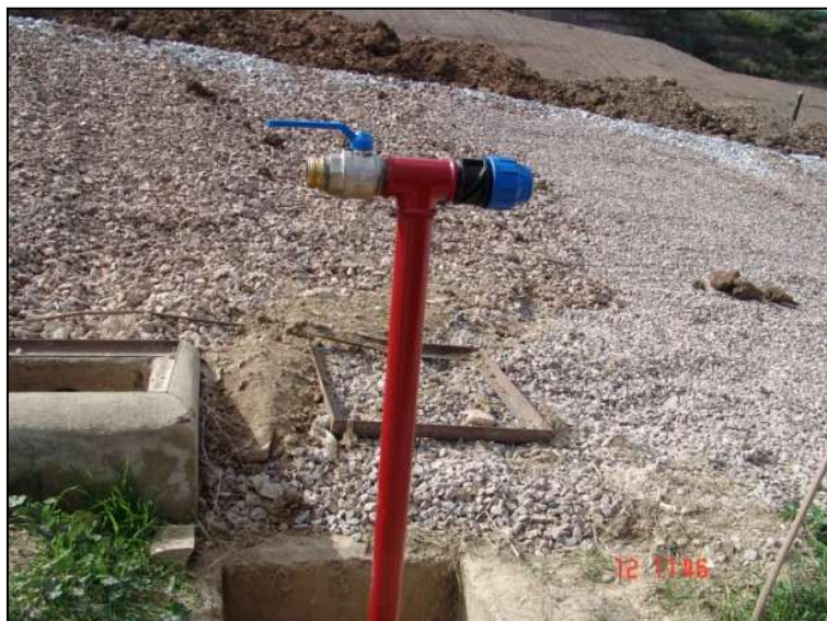
Figura 2.3/VII: Particolare pozzetti di allaccio idranti
