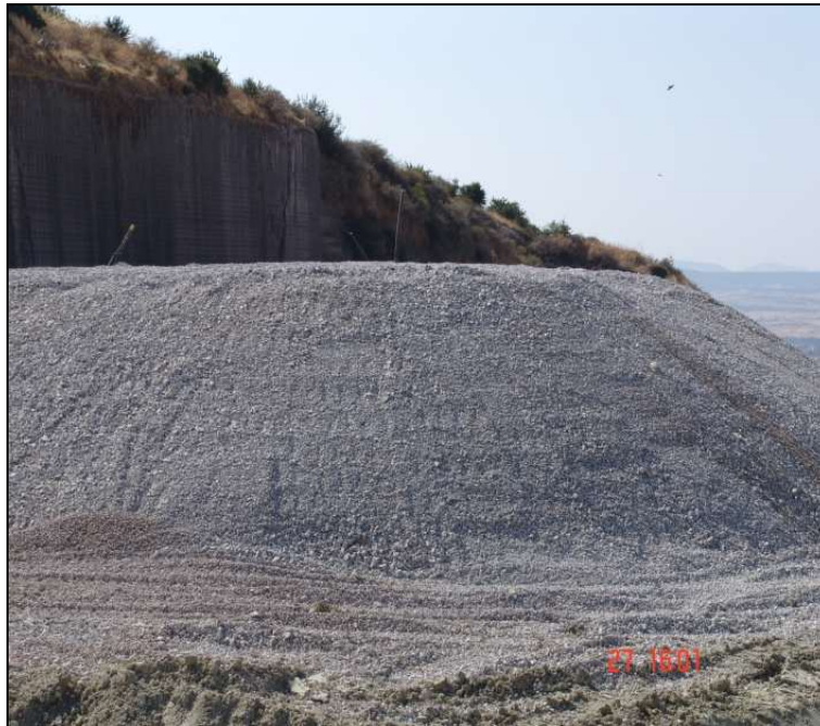
Figura 2.5/II: Stesa strato di rottura capillare
