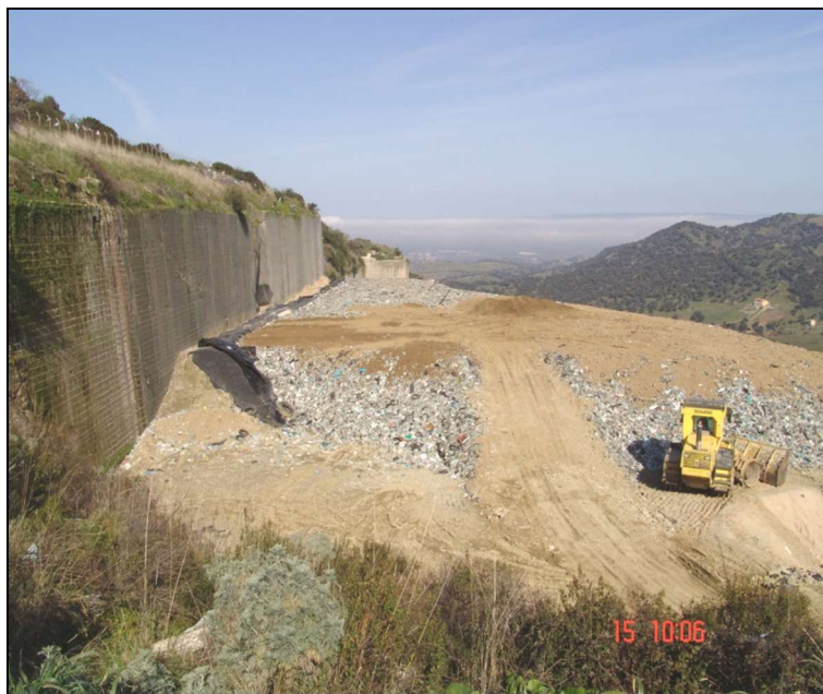
Figura 2.5/I: Stesa strato di regolarizzazione
