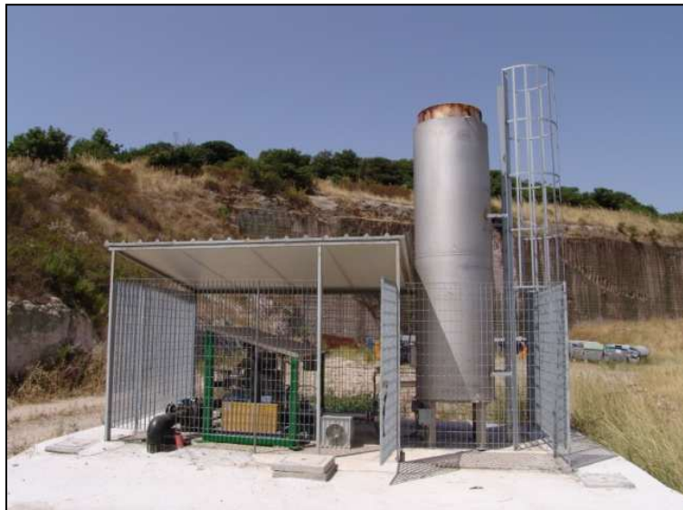
Figura 2.5/IX: Torcia di combustione biogas
